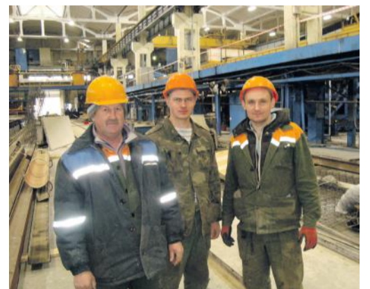
Звено СМУ-2 по устройству фундамента. Слева направо: бригадир А.П. Коренчук , специалисты звена Р.В. Чубраев и Н.А. Кручек
